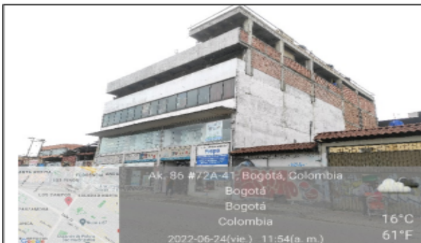
Foto 1. Vista panorámica del sitio de origen de la valla en la Av. Carrera 86 No. 72 A - 41 (dirección catastral) Orientación Norte – Sur.
