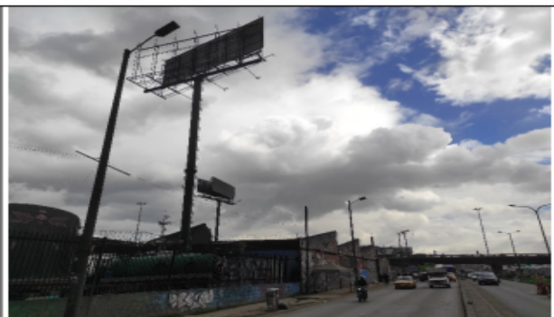
Foto 4. Vista en detalle del panel, actualmente no instalado.
